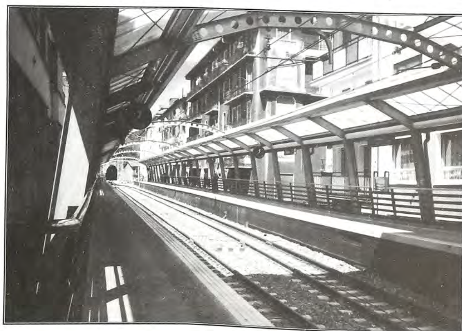
Vista de los Andenes.
