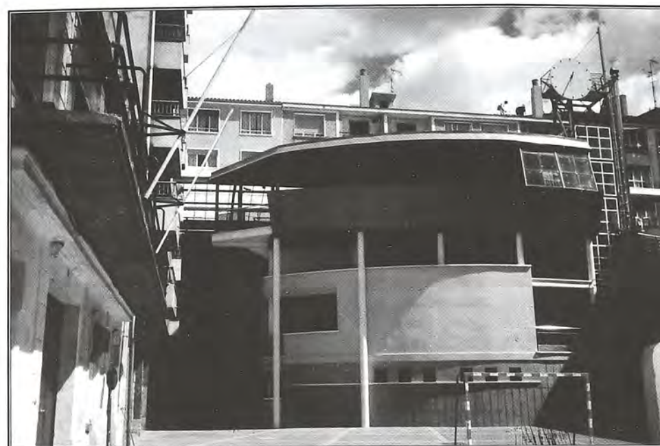
Vista de la Estación.
