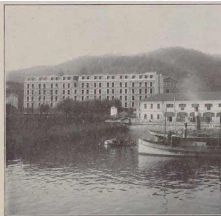
PASAJES — Edificios para viviendas del personal de pesca, levantados por la Sociedad Anónima «Muelles y Almacenes para Vapores de Pesca»
