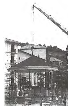
Colocación de la cubierta del kiosko. (Foto Cano)
